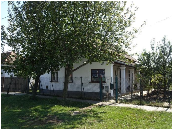
18. kép: Jellegzetes családi lakóház 2.
