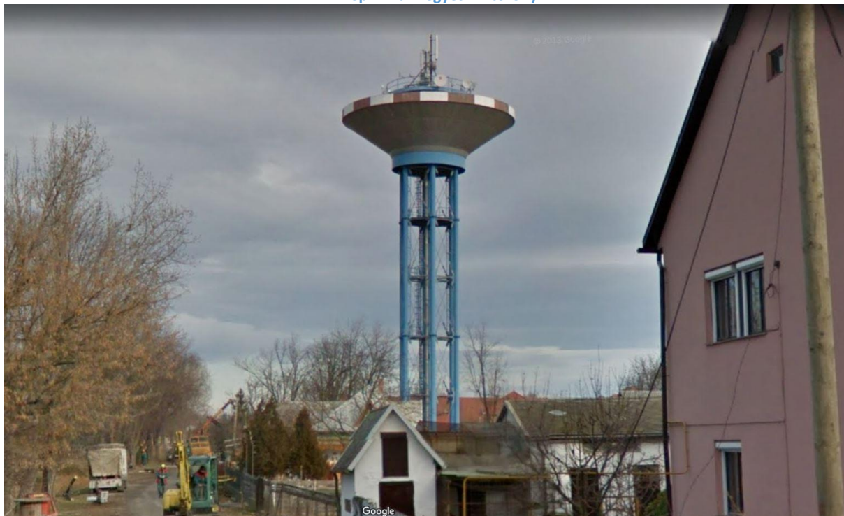
74. kép: A kunhegyesi víztorony
