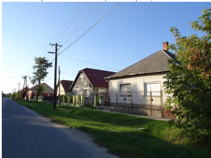
58. kép: Oldalhatáron álló épületelhelyezés, előkertekkel
