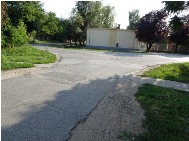
37. kép: Jellegzetes településszerkezeti elemek, teresedések, útelágazások 1.
