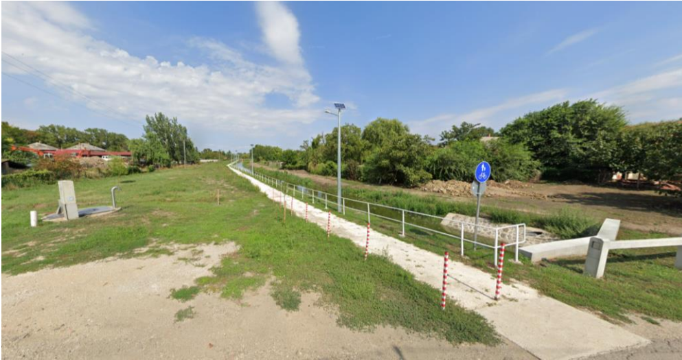
75. kép: A megépült sétaút életvédelmi korlátot és a közvilágítás kandeláberek
