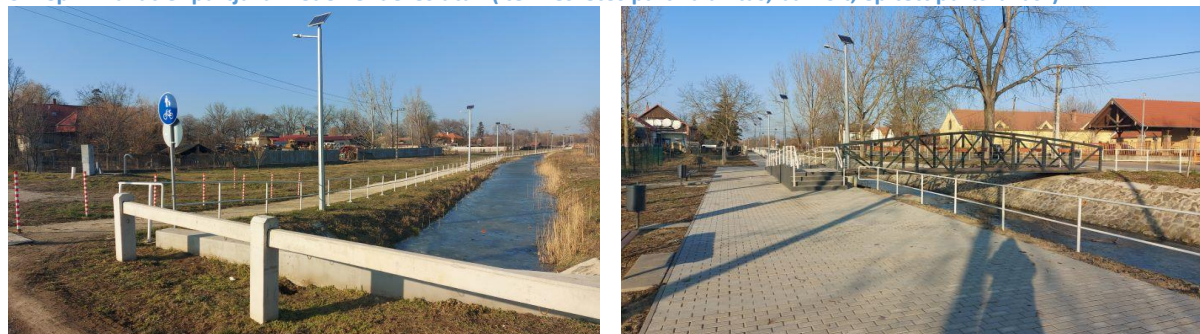
3. kép: A Kakat-ér partjai a mederrendezés után (természetes partkialakítás, burkolt, épített partszakasz)
